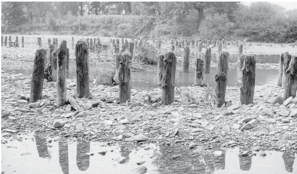
Fot. 1. W wyniku erozji wgłębnej poniżej zapory w Czańcu odsłonięte zostały palisady dawnych mostów zniszczonych przez wcześniejsze powodzie
